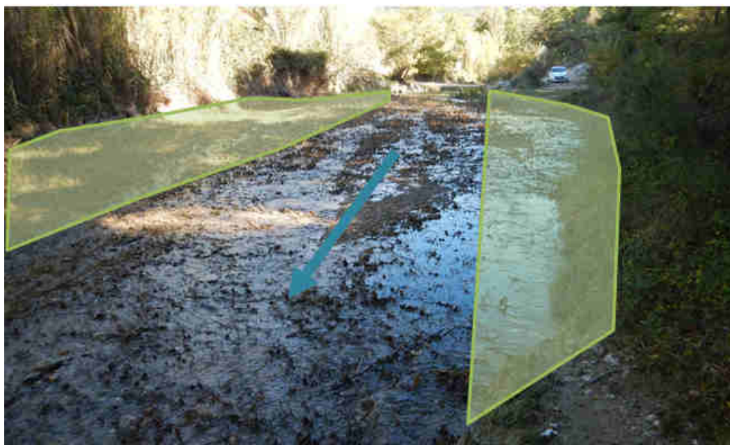
Figure 41 : Localisation de la restauration de berge gauche et de la création de risberme droite – Vue aval
