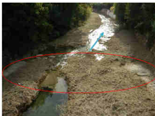
Figure 3 : Seuil de la passerelle de la Gendarmerie – vue depuis l'amont
