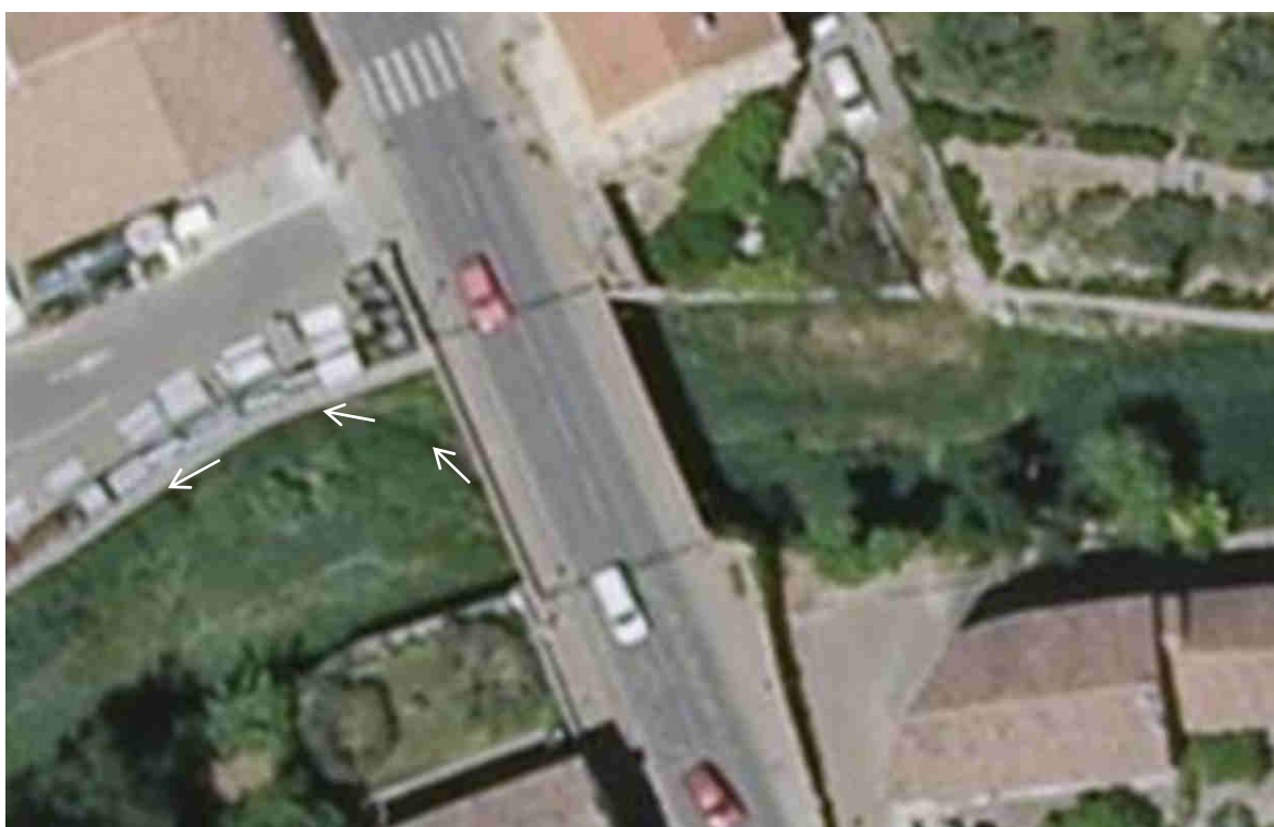
Figure 24 : Tracé actuel du cours d'eau au niveau du pont de la RD21 et localisation des épis déflecteurs
