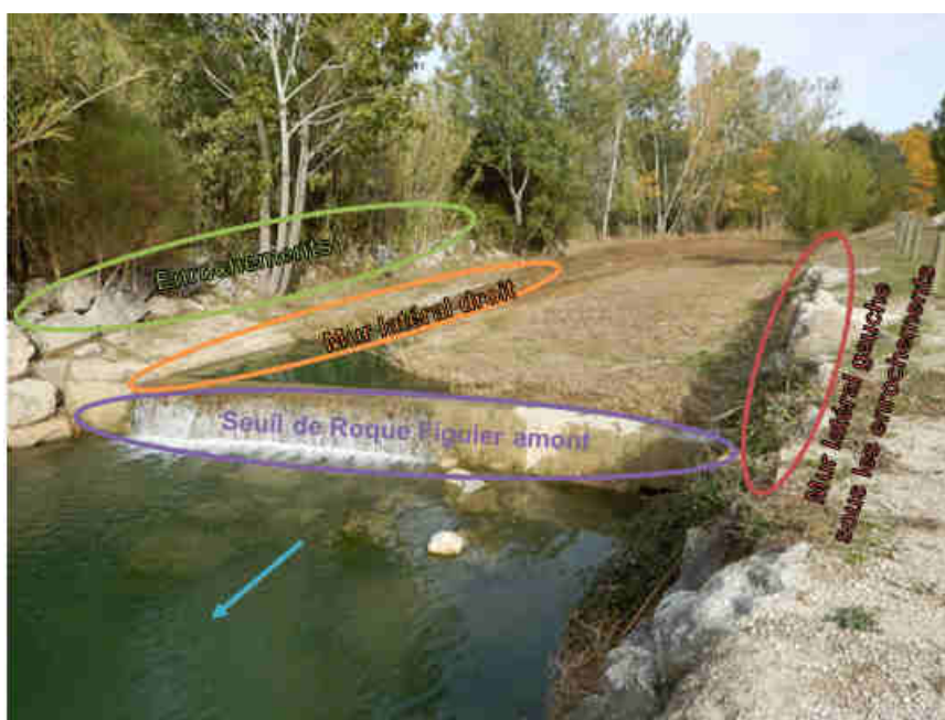
Figure 11 : Seuil de Roque Figuiet amont et autres éléments de l'ancienne piscine
