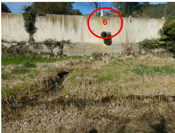
Figure 27 : Exutoires pluviaux présents sur le secteur
