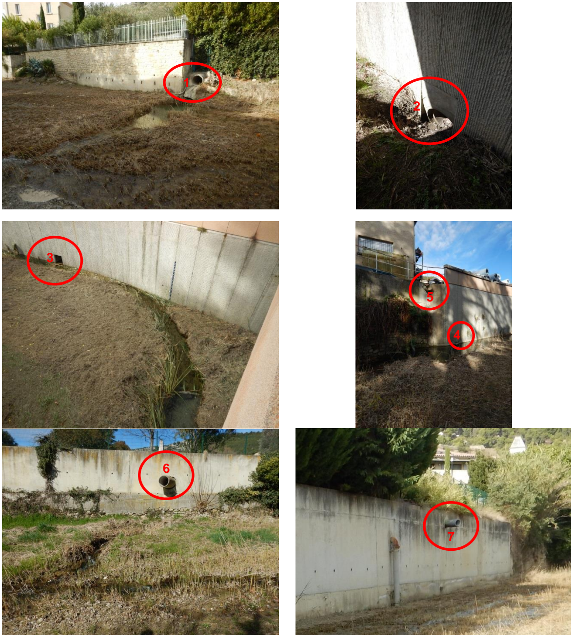
Figure 27 : Exutoires pluviaux présents sur le secteur
