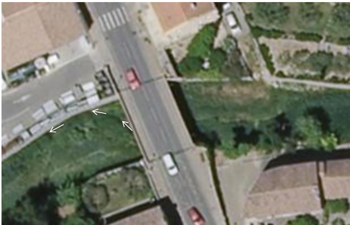
Figure 23 : Tracé actuel du cours d'eau au niveau du pont de la RD21 et localisation des épis déflecteurs
