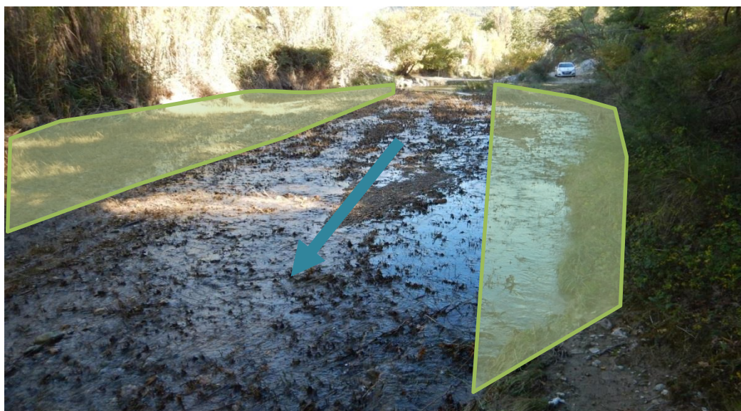
Figure 41 : Localisation de la restauration de berge gauche et de la création de risberme droite – Vue aval
