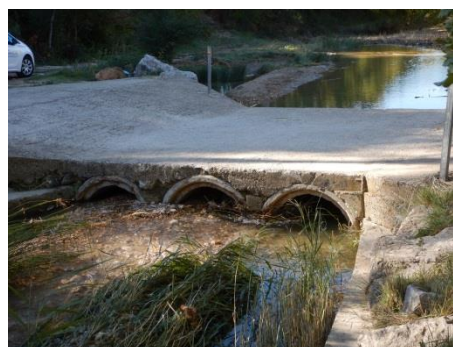
Figure 37 : Dépôts sédimentaires obstruant les buses du gué de Rocalinaud
