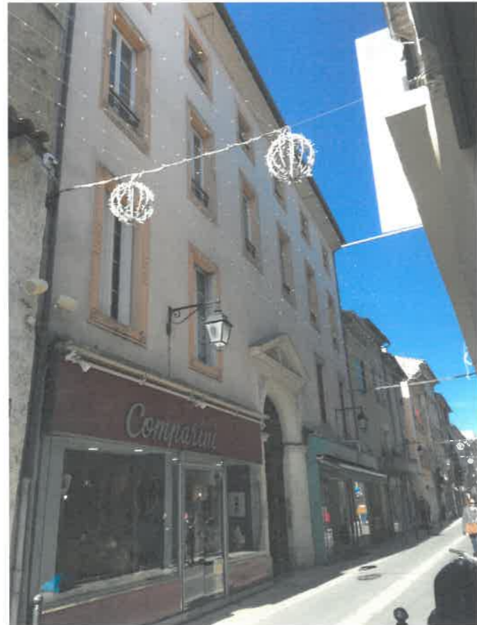
Ancienne rue Droite, alignement d'anciens hôtel particuliers
