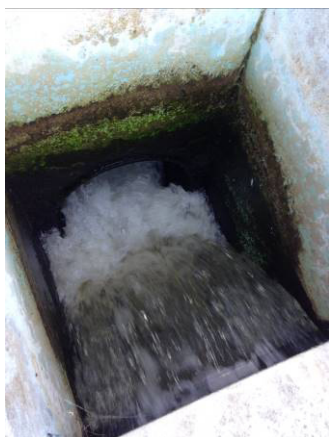
Figure 3. Sortie clarificateur existant
