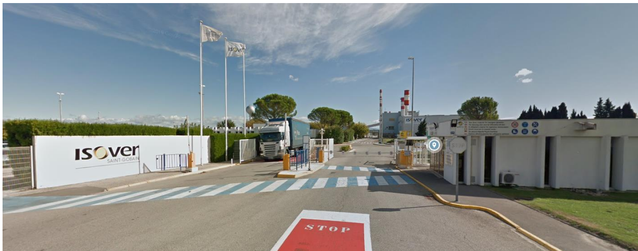
Vue du site depuis l'Ouest (entrée du site, rue du Portugal)
