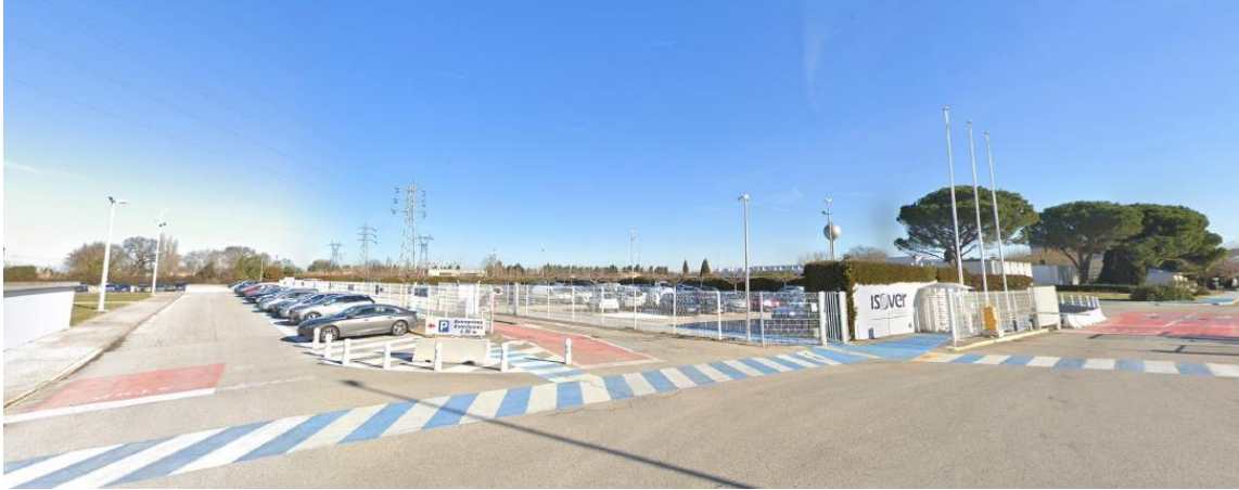
Vue n°1 : Parking état des lieux
