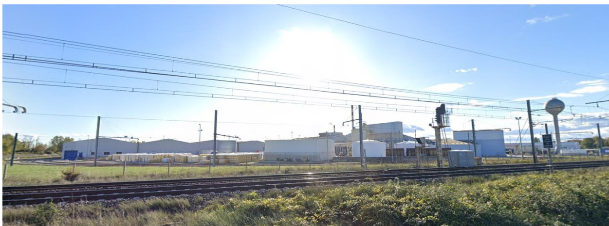
Vue du site depuis le Nord-Est (Chem. du Ramas)
