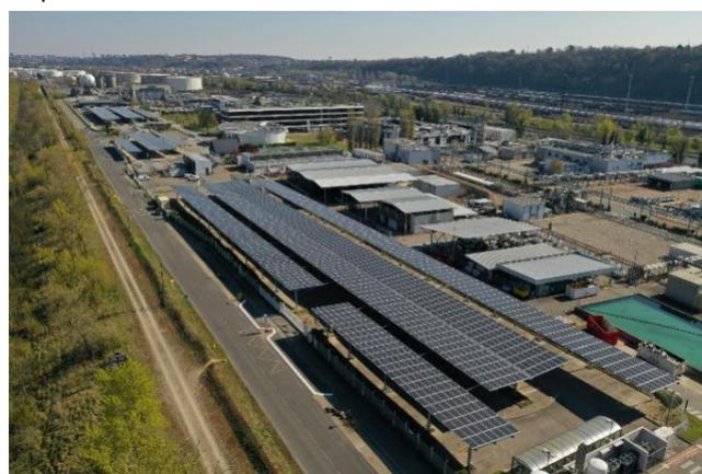
Terre et Lac a développé et construit la première centrale photovoltaïque de Haute-Savoie avec 2,5 MWc implantés sur une ancienne décharge, à Faverges-Seythenex. 25% de la production est injecté sur une boucle locale pour fournir de l'énergie sur le territoire.
